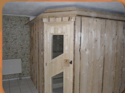
unbesäumte Bretter, außen
